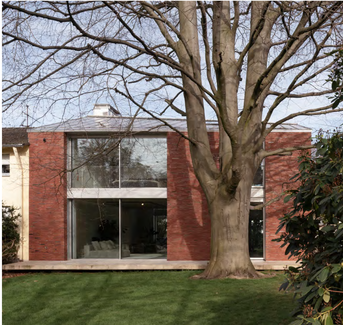
Einfamilienhaus, Köln cero III Ref. 1892
